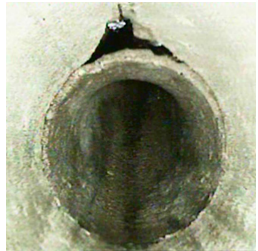
Det er typisk huller som disse der kan klares med en strømpeforing
